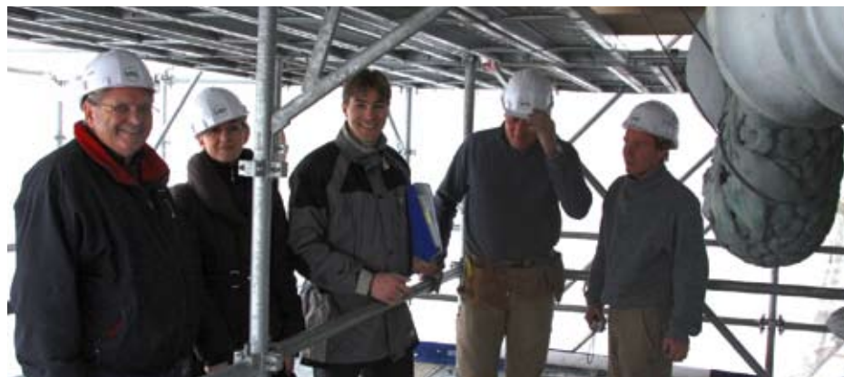
Baubesprechung: Am Girlandengehänge unterhalb der Eisengitter-Brüstung stehen Albert Sporer aus München, seine langjährige Dolmetscherin Valérie Lesur aus Lyon sowie UTB-Bauleiter Julian Soccard und zwei seiner Spengler
